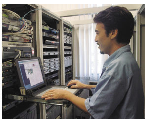
メインのサーバールームにて、ラック収納型のコンソールを使用する宮下氏。基本的には、リモートデスクトップやVNCを利用した遠隔管理が便利で簡単だという。
