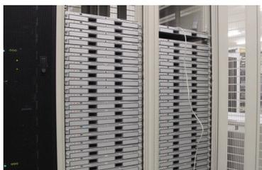
ブレードサーバは46台のXserve G5 (2.0GHz / メモリ2GB)で構成。Xgridの制御などには、別のXserve G5 (デュアル2.0GHz / メモリ2GB)が充てられている。ファイルサーバはIBM製品を使用。
